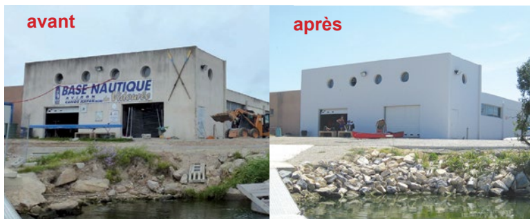
La façade du hangar de la Base Nautique Intercommunale du Vidourle ( Le Grau du Roi ) qui héberge les associations Kayak Club Terre de Camargue et Aviron Club Terre de Camargue a fait peau neuve. La signalétique d'identification sera peinte dans la foulée.
