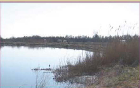
Station d'épuration (lagunage) de Saint Laurent d'Aigouze 2005-2006
