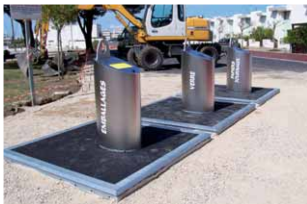
Pour le tri sélectif, les containers enterrés.
