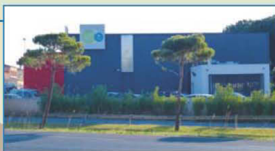
Bâtiment d'affermage SDEI (Le Grau du Roi) - 2008
