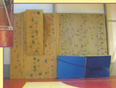
Construction d'un mur d'escalade Salle Camargue - 2006
