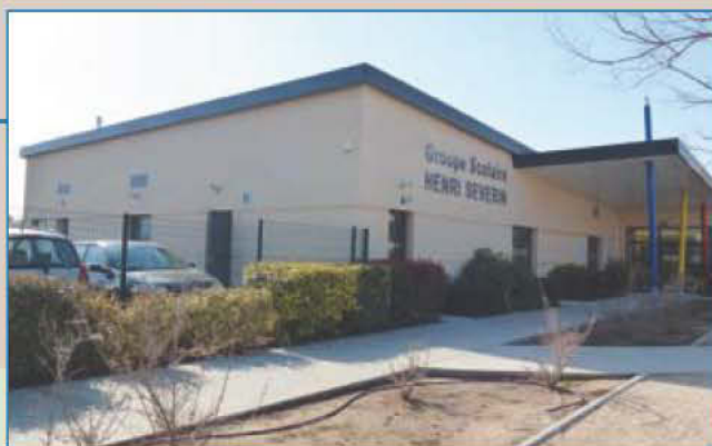
Construction du restaurant scolaire intercommunal Henri Séverin (Aigues-Mortes) 2004
