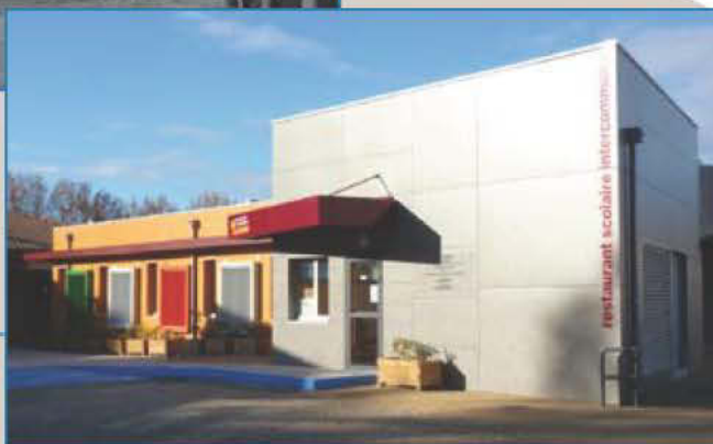
Construction du restaurant scolaire intercommunal Chloé Dusfourd (Saint Laurent d'Aigouze) 2011
