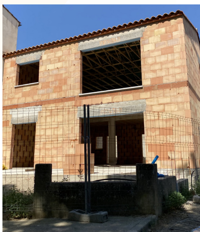
Logement individuel en construction à Saint-Laurent d'Aigouze
