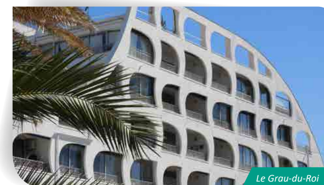
Source : Service communication - CC Terre de Camargue
