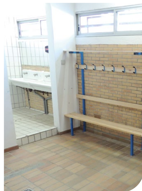
Les vestiaires rénovés du stade Maurice Fontaine
