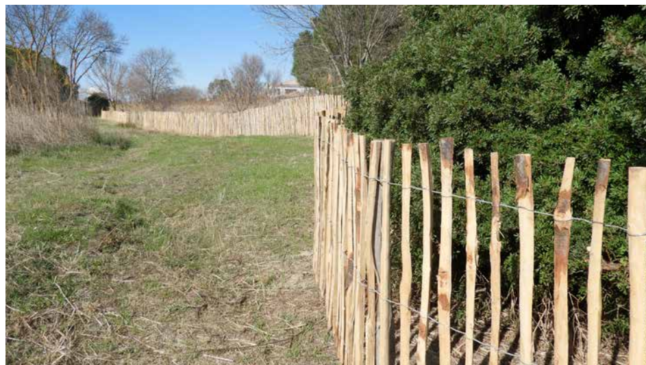
Aménagement d'une ganivelle, pinède du Boucanet
