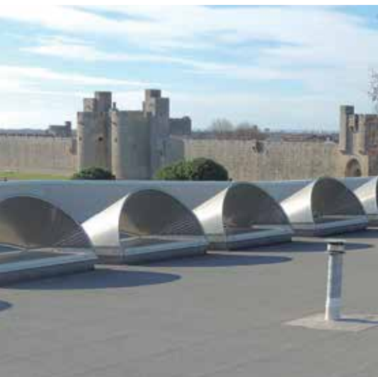
Nettoyage et étanchéité des 500 m 2 de toiture de la salle Camargue
