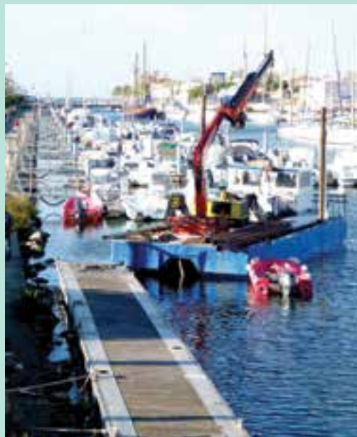
Travaux effectués en novembre au Grau du Roi.
