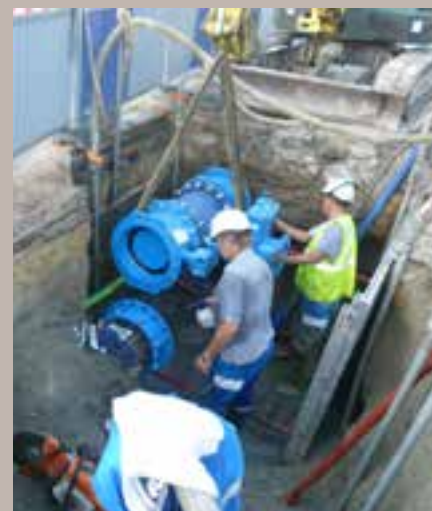
Raccordement sur la canalisation en fonte de diamètre 400mm au niveau de l'hôtel des 4 vents.
