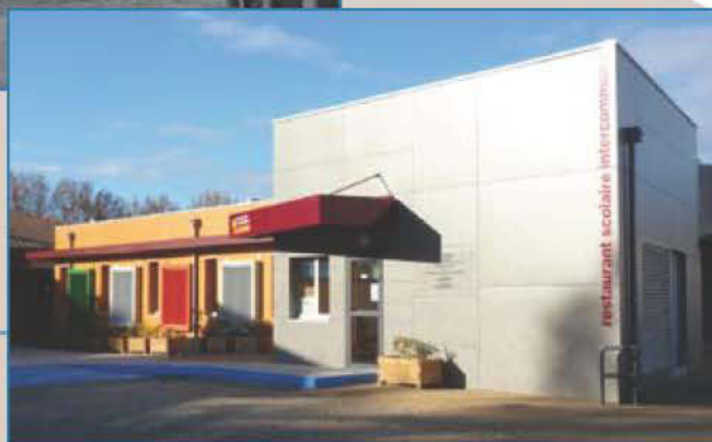
Construction du restaurant scolaire intercommunal Chloé Dusfourd (Saint Laurent d'Aigouze) 2011
