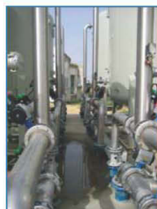
Traitement des pesticides (Hors territoire) Construction d'une unité de traitement des pesticides au cap- tage d'eau potable des Baïsses (Aimargues) 2008 -> 2012
