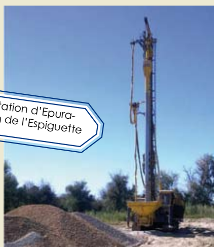
Engin pour l'installation de colonnes ballastées
