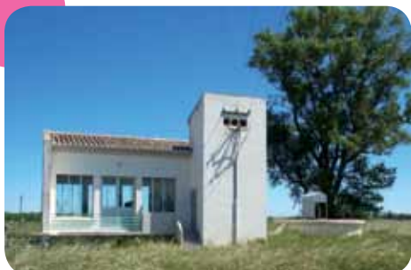
Station des Baisses- Captage d'Aimargues
