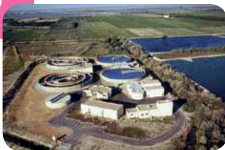
Station d'épuration du Grau du Roi
