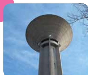
Château d'eau du Grau du Roi
