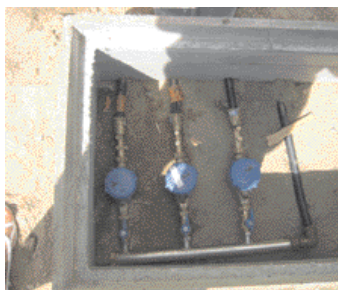
Nouveaux branchements en PEHD (Photos service réseaux CCTC)
