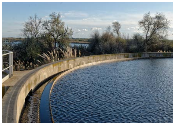
Les 3 communes sont désormais raccordées à la station d'épuration intercommunale au Grau du Roi qui affiche un taux d'épuration de 97 % en sortie de station, avant traitement par lagunage.
