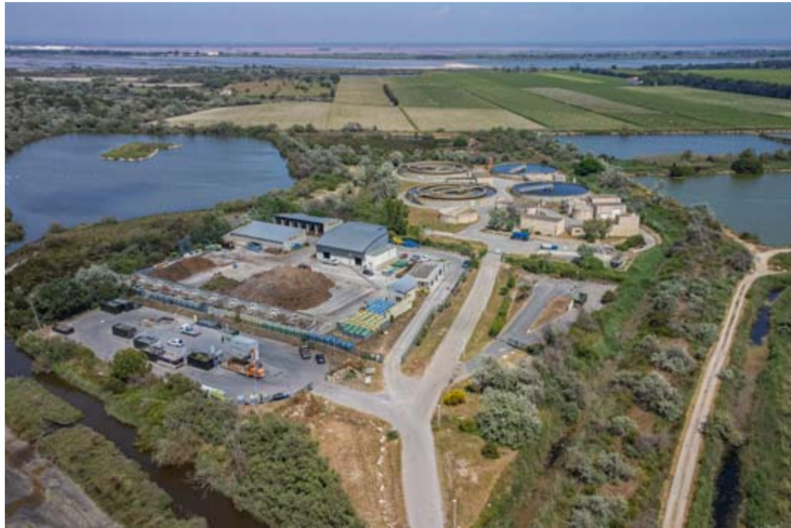
La communauté de communes de Terre de Camargue étudie la possibilité de réutiliser l'eau de sa station d'épuration intercommunale du Grau-du-Roi. PHOTO SUEZ / AGENCE NEA
