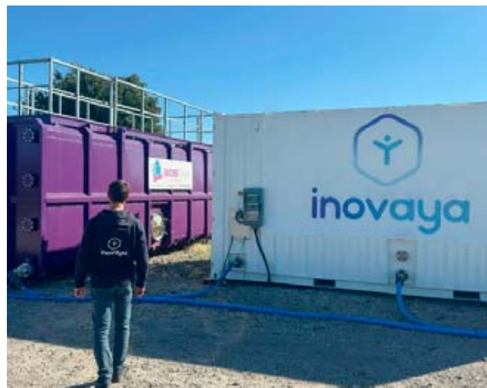
Sur la base travaux SNCF Réseau de Nîmes, les eaux usées traitées, reconnaissables à leur stockage dans des citernes violettes, sont testées à Nîmes pour rabattre les poussières sur les chantiers ferroviaires. PHOTO SNCF RÉSEAU
