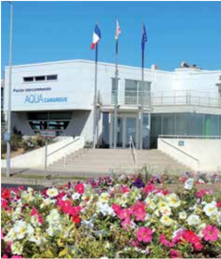
Piscine intercommunale Aqua Camargue
