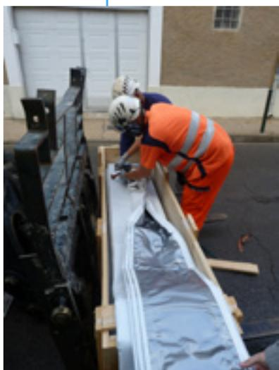
Cette technologie de pointe, performante, économique et écologique, consiste à introduire une gaine à l'intérieur de la canalisation en passant par les regards de visite, sans ouvrir de tranchée. Gonflée et chauffée, la gaine va durcir pour créer une nouvelle canalisation à l'intérieur de l'ancienne. Depuis 2008, 17,2 km de canalisations d'assainissement et d'eaux pluviales ont été ainsi remis à neuf.
