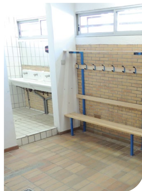
Les vestiaires rénovés du stade Maurice Fontaine
