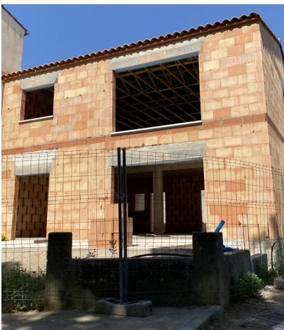
Logement individuel en construction à Saint-Laurent d'Aigouze
