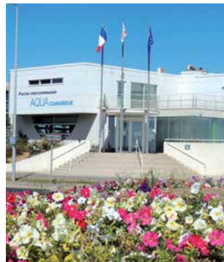
Piscine intercommunale Aqua Camargue
