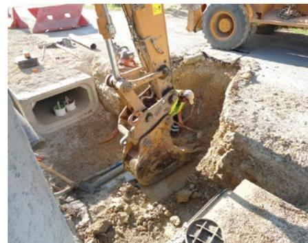
Dans le cadre des travaux d'aménagement (décidés par la mairie de Saint-Laurent-d'Aigouze) de l'avenue Jacques et Casimir Raynaud, les travaux de mise en place du réseau d'évacuation des eaux pluviales ont été réalisés.
