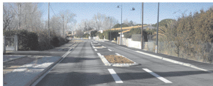
Le chemin après les travaux d'aménagement. (Photos service réseaux)
