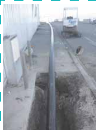
Pose de la nouvelle conduite (photo service réseaux)
