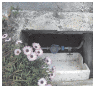
Branchements en plomb avant les travaux. (Photos service réseaux CCTC)
